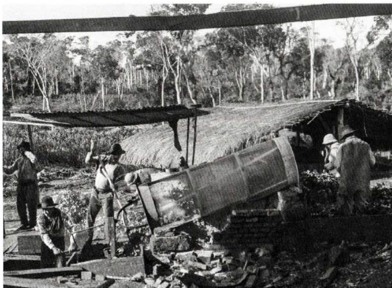
Fotografía 1. Sapecado de yerba mate en Puerto Esperanza, ca. 1930
